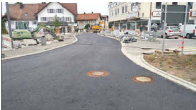
Bituminöse Tragschicht im Einfahrtsbereich Bahnhofstraße
