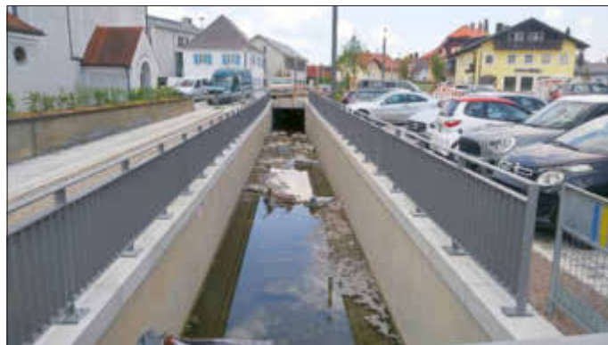
Absturzgeländer Ufermauer entlang Friedhof
